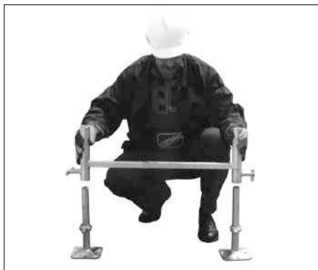
Rys. 3. Montaż nakładki na podstawki śrubowe
