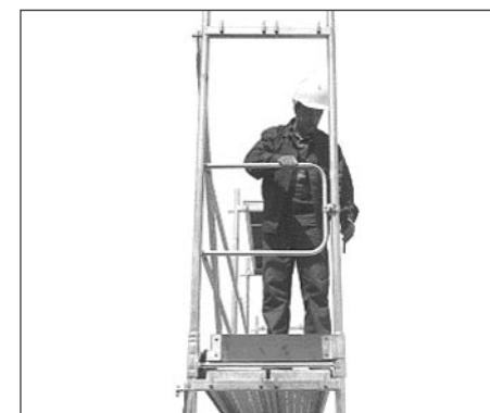
Rys. 15. Montaż poręczy poprzecznej
