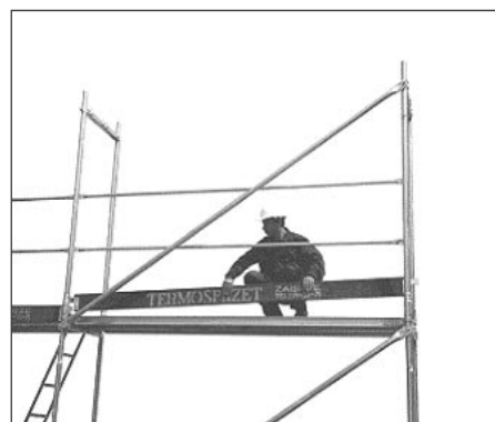
Rys. 14. Zakładanie deski burtowej
