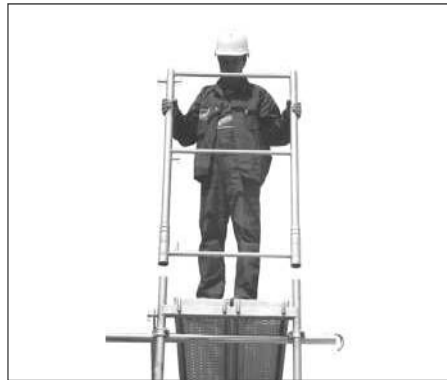
Rys. 19. Zakładanie ramki górnej
