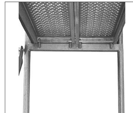
Rys. 7. Pierwsze pole rusztowania o szerokości 0,8 m z nałożonymi podestami
