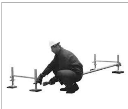
Rys. 4. Zakładanie stężenia poziomego
