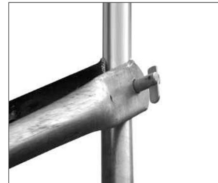
Rys. 21. Mocowanie stężenia na sworzniu z zapadką
