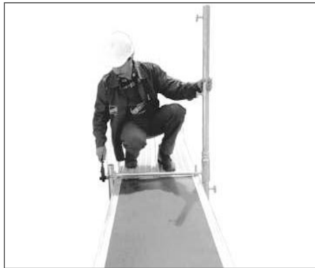
Rys. 18. Montaż ramki L 0,8 m
