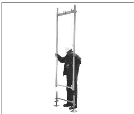
Rys. 5. Montaż ramy na nakładkę podstawki śrubowej
