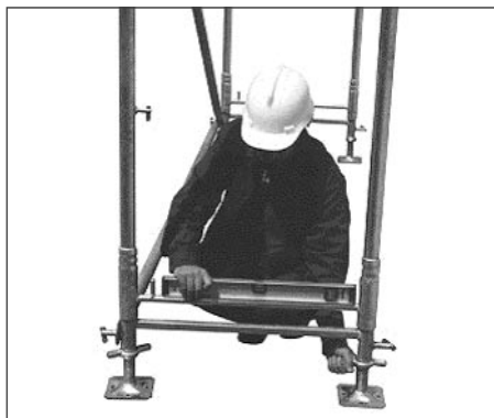
Rys. 11. Poziomowanie rusztowania
