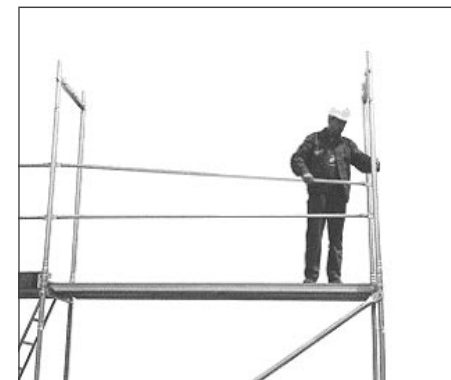
Rys. 13. Montaż poręczy drugiej kondygnacji
